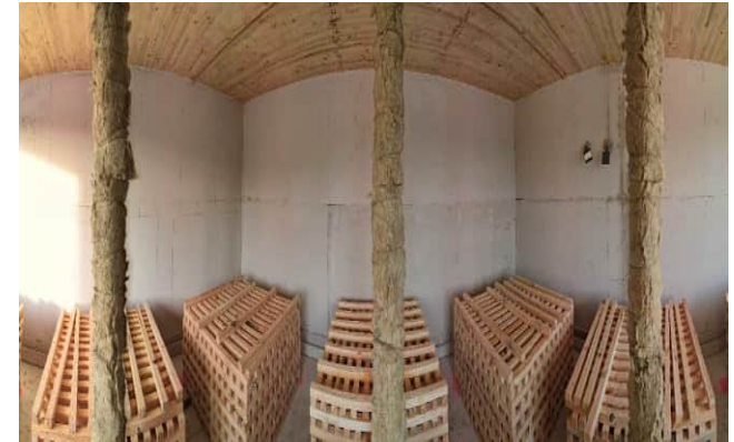
sichtbare BSH Decke, Wände mit 1 x 18 mm Gipsbekleidung
