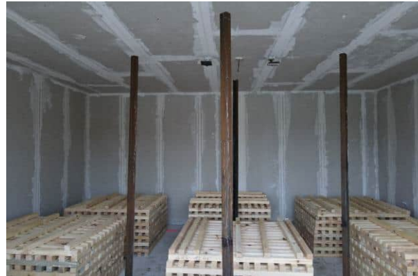
allseitig nicht brennbare 2 x 25 mm Gipsbekleidung
